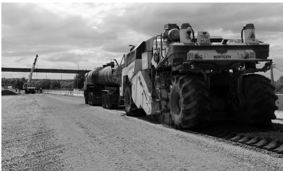
Сразу два новых этапа работ начались на участке реконструкции автодороги к мосту через Малый Цивиль в Шихазанах. Мостовики выполнили монтаж металлического пролета надземного пешеходного перехода, дорожные строители приступили к усилению дорожной одежды методом холодной регенерации на участке в районе поста ДПС длиной 350 метров, что позволит на следующей неделе приступить к укладке асфальта на левой стороне автодороги.
