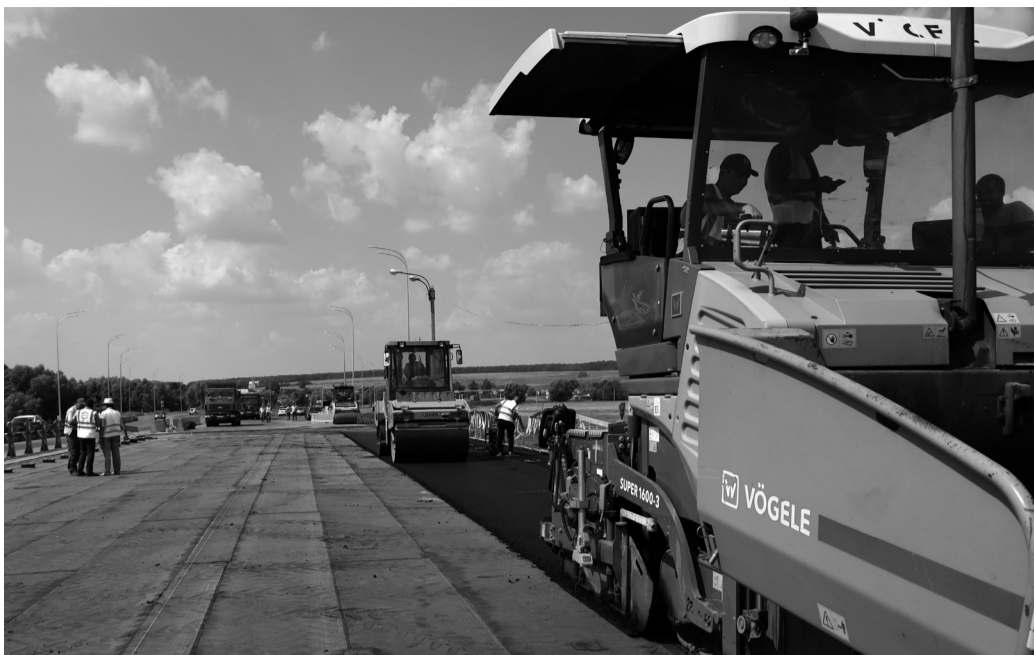
На левом сооружении моста через реку Малый Цивиль уложили асфальт
