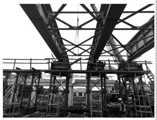
На реке Сюнь мостовики готовятся к надвижке пролетного строения и сдаче под асфальт левого сооружения моста через реку.
